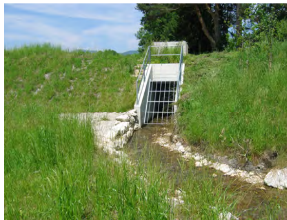
Immagine 25 Acquedotto sotterraneo con rete
