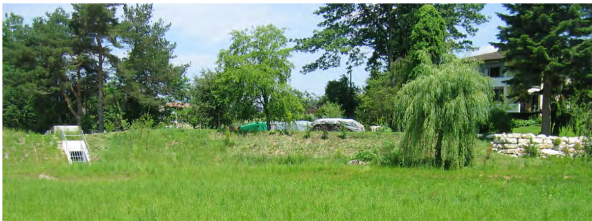
Immagine 26 Vasca di ritenzione e infiltrazione
