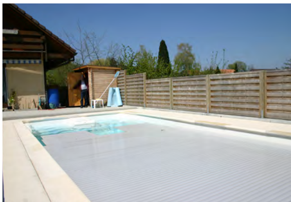
Immagine 17 Copertura con chiave, interruttore, e campo visivo libero
