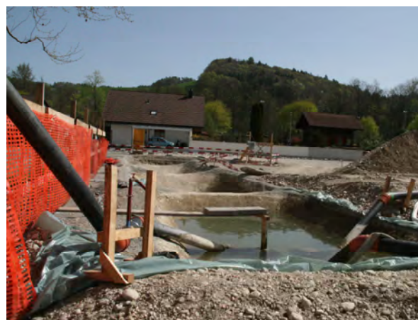
Immagine 2 Evacuazione delle acque di cantiere in fosse
